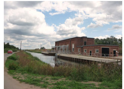
Fig 1. Welches Dam P.S.
